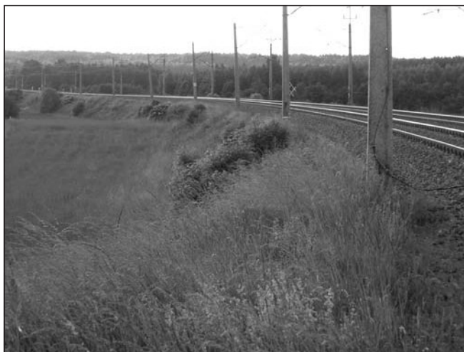
Rys. 2. Linia E65 przecina korytarz ekologiczny rzeki Mławki i po modernizacji może stanowić istotną barierę ekologiczną. Dla płazów już w swej obecnej postaci powoduje zagrożenie izolacji
