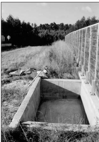
Rys. 6. Fragment powierzchni mostu prezentowanego na rys. 4. Celem dokładnego zważenia gleby i dolnej warstwy drobnych filtrujących kamyczków – zawartość 1 konteneru wybrano i określono ciężar
