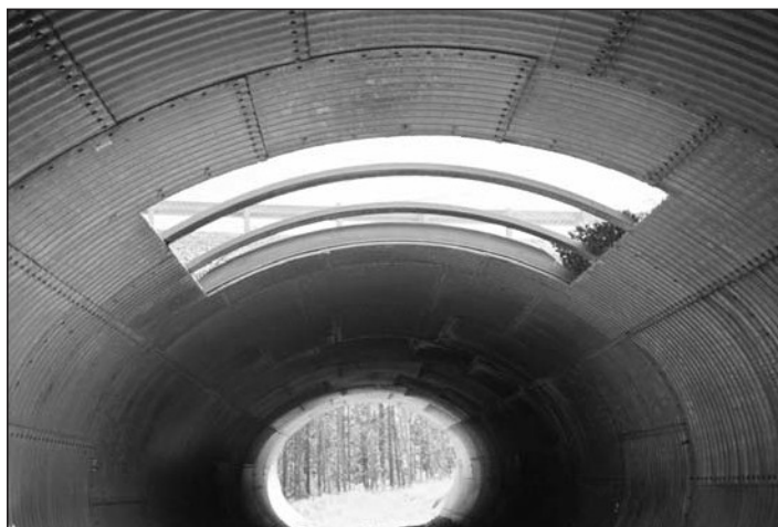
Rys. 8. Doświetlenie przejścia pod drogą w pasie rozdziału
