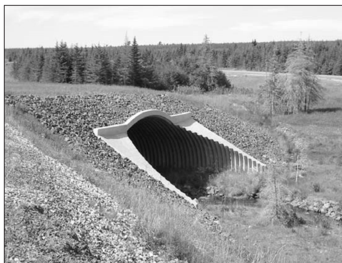
Rys. 9. Przykład przejścia dla zwierząt pod autostradą, Kanada
