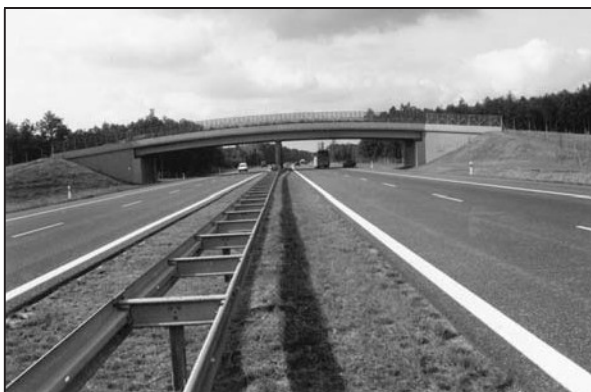
Rys. 2. Most z ażurowym parkanem w km 217,7 zlokalizowany wśród lasów. „Lejki” nie obsadzone drzewami ani krzewami
