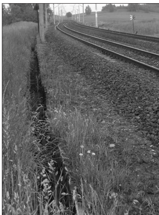
Rys. 4. „Korytka krakowskie” służące do odwodnienia nasypu linii kolejowej stanowią barierę dla płazów i innych zwierząt
