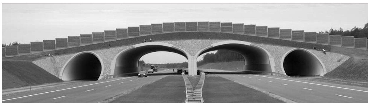
Rys. 4. Widok zrealizowanego ekomostu
