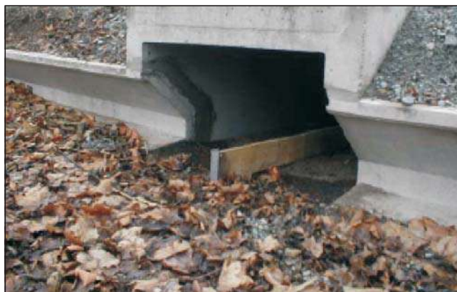
Rys. 6. Tunele i płotki naprowadzające typu ZIEGER dla płazów. Istotne jest zachowanie naturalnego podłoża i umieszczenie deski naprowadzającej w środku tunelu
