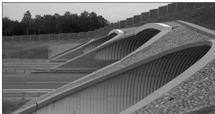
Rys. 5. Sposób wykonania obiektu na jego końcach
