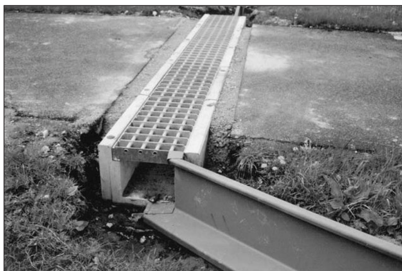
Rys. 8. Przepust na jednej z dróg Belgii zbudowany na równi z powierzchnią jezdni
