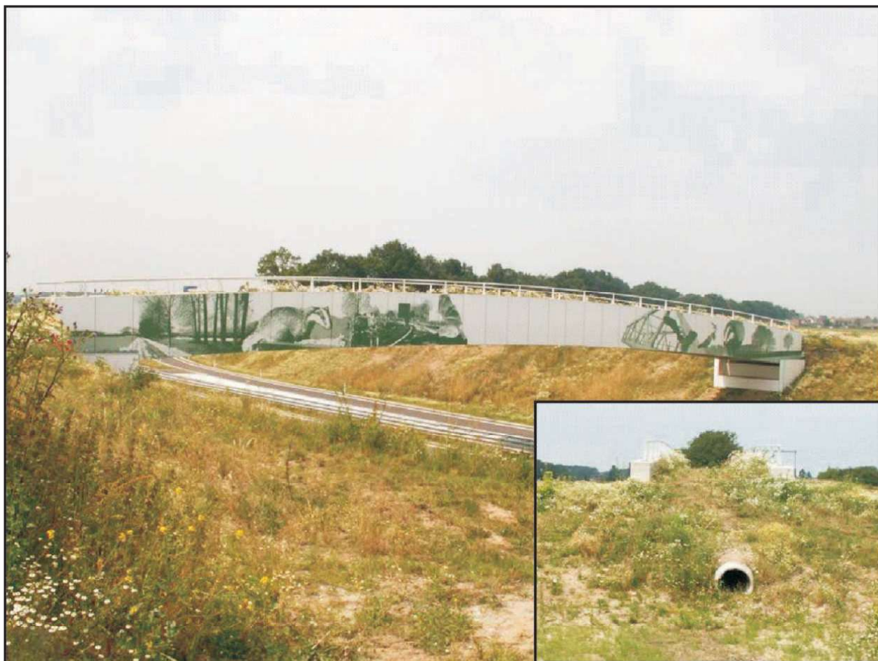
Rys. 6. Ekombidukt jest połączeniem ekoduktu i tunelu dla borsuków
