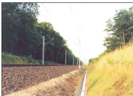
Rys. 4. Miejsce lokalizacji przejścia górnego na 470,199 km (Fot. R. Kurek)
