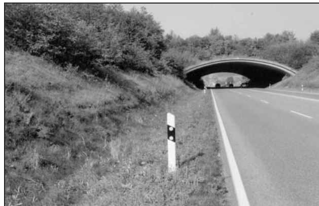
Rys. 10. Niemcy. Droga B31. Jeden z kilku mostów dla zwierząt o szerokości 33 metrów. Jezdnie drogi w rejonie mostu zostały obniżone
