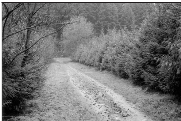
Rys. 9. Belgia. Most nad autostradą Bruksela-Luksemburg w rejonie leśnym. Ma tylko 8 metrów szerokości, ale jest za to bardzo dobrze zagospodarowany. Poziom powierzchni mostu został zrównany z poziomem otaczającego lasu. Korzystają z niego sarny
